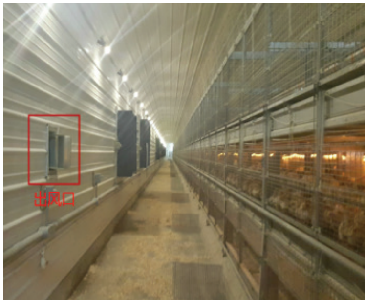
上、下：笼养/产蛋鸡舍内 带出风口的Guardian 250箱式育雏取暖器。
