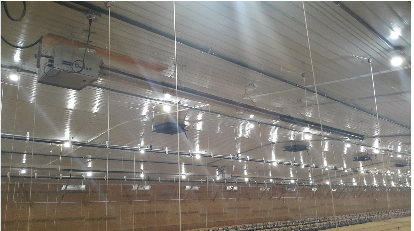
上、下：一处禽舍内悬挂的Oval 80辐射管式育雏取暖器。
