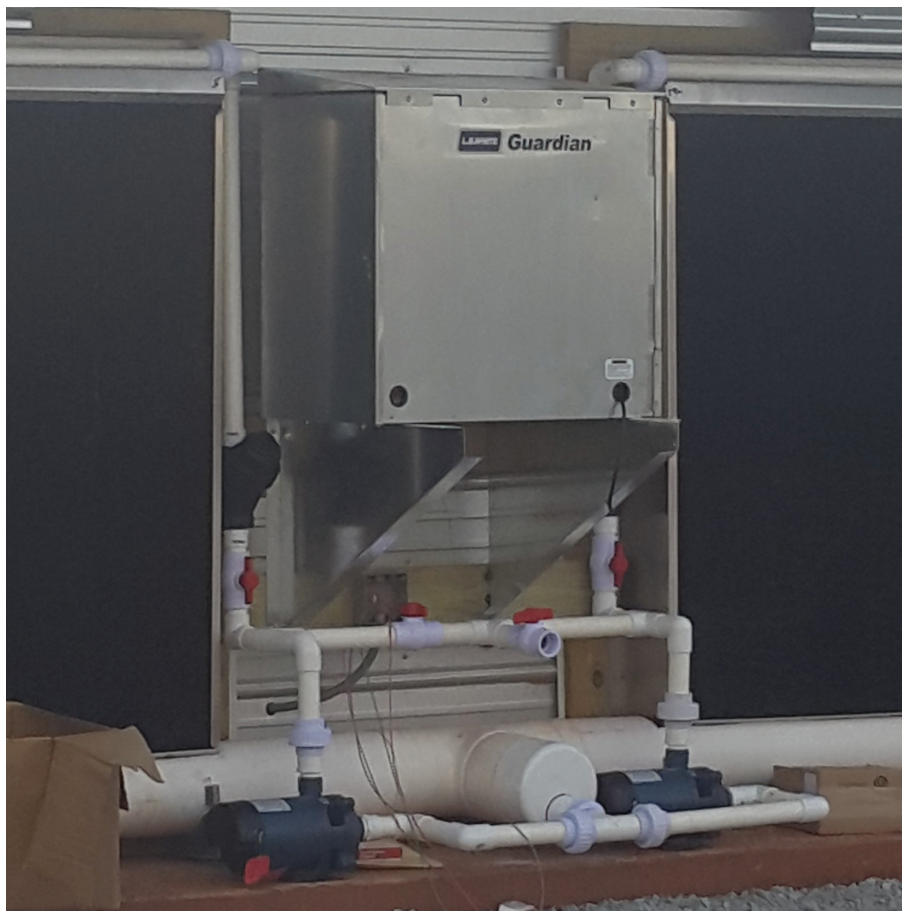
左、下：在一处禽舍外，托挂 Guardian 325箱式育雏取暖器的室外装置组合。
