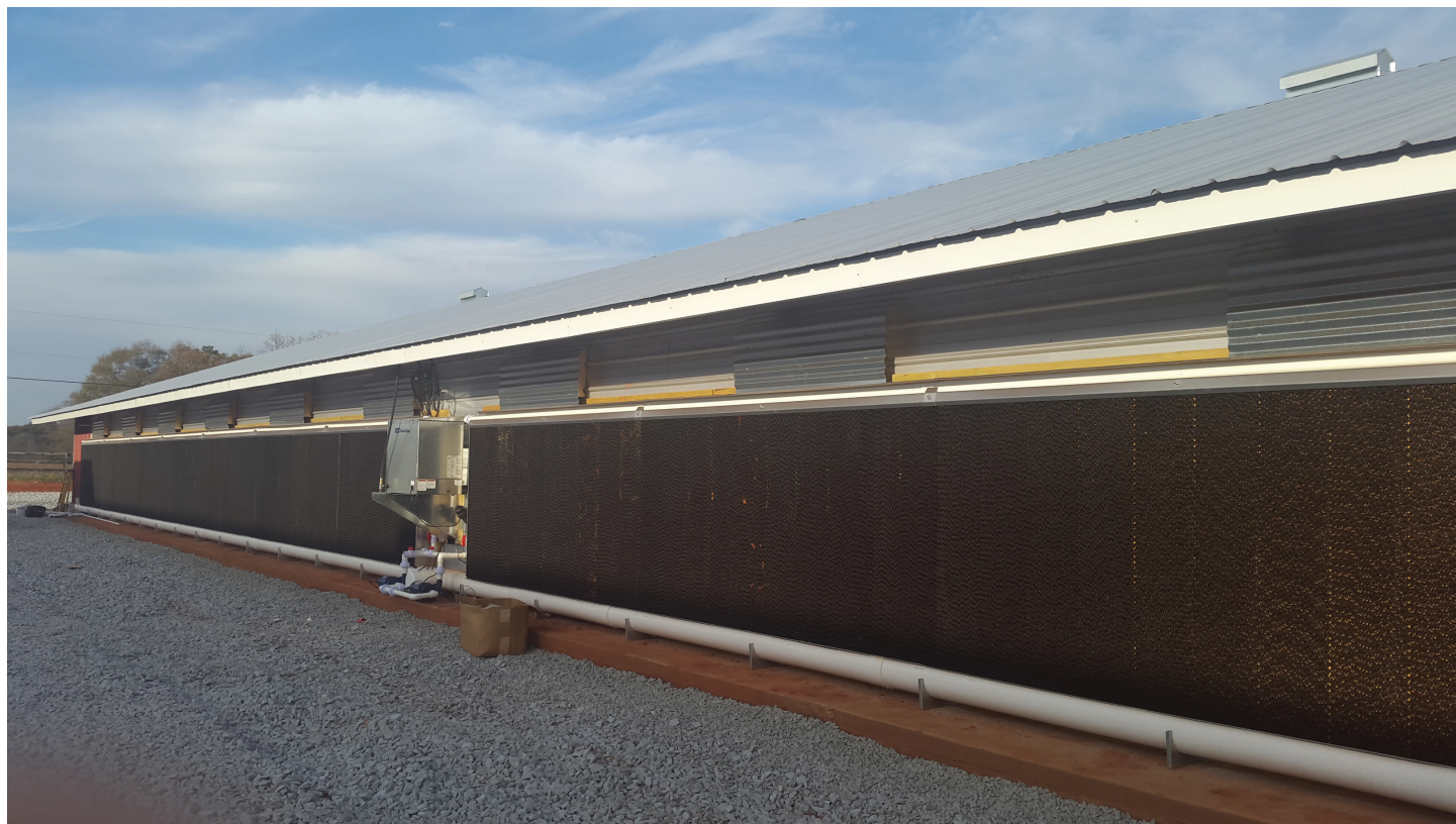
下：Guardian 250箱式育雏取暖器（带有室外安装组合）安装在一处禽舍的外侧。
