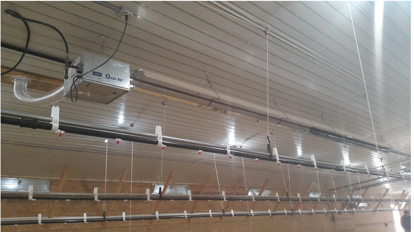
上、下：一处禽舍内悬挂的Oval 80辐射管式育雏取暖器。
