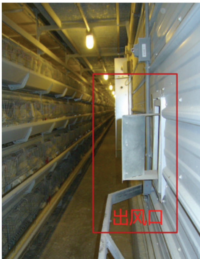
上、下：笼养/产蛋鸡舍内 带出风口的Guardian 250箱式育雏取暖器。
