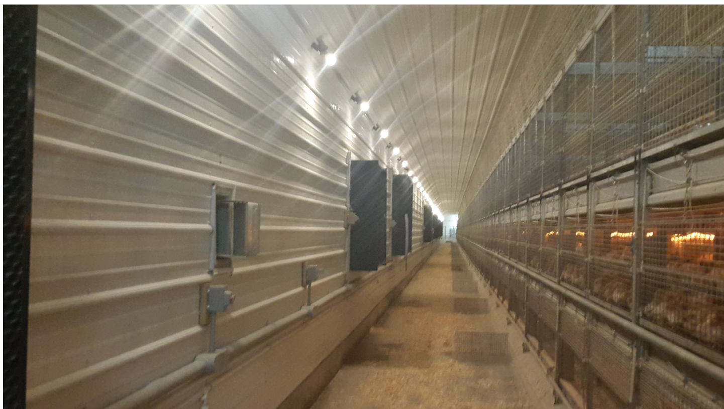
上：Guardian箱式育雏取暖器的空气分流器（出风口）分布在蛋鸡舍的一侧
