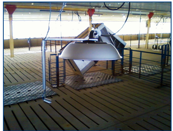
Un appareil de chauffage à air pulsé L.B. White et une couveuse à chauffage par rayonnement Smart Sense.
