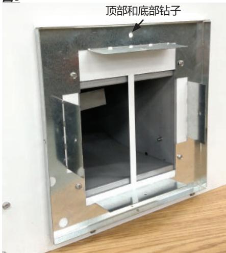
3. 将带挡板的内部通风管道装至卸取法兰的 4 枚内部悬挂片上。详见图9。
