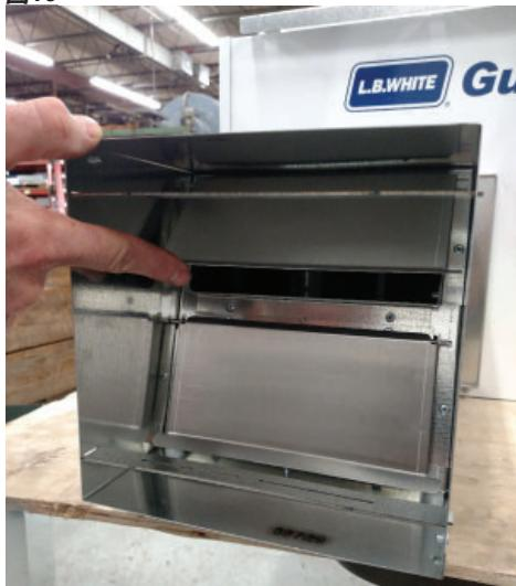
利用 4 枚 F 项所对应的螺钉将外部通风管道固定至卸取法兰的外沿处。详见图11。妥善紧固所有部件。
